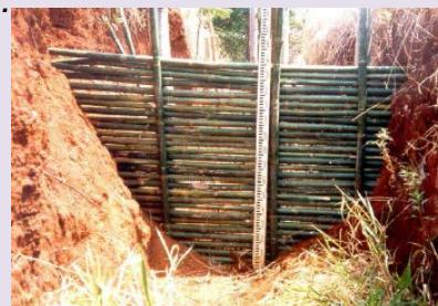
ETAPA 1 - Paliçada de bambu para contenção da enxurrada.
